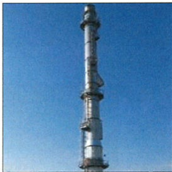
ภาพที่ 2.2-2 ปล่องหน่วยเผาทำลายก๊าซและของเหลวที่เหลือจากการผลิต (Thermal oxidizer ; TOX) และระบบ CEMS
