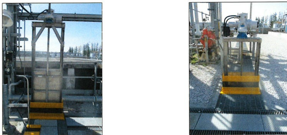
ภาพที่ 2.2-36 การติดตั้งประตูกันน้ำบริเวณรางระบายน้ำฝนบนเพื่อก่อนเข้าบ่อพักน้ำฝนบนเพื่อก
